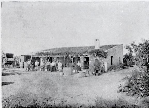
FACCIATA DELLA CASA FAGIANI DOMENICO
