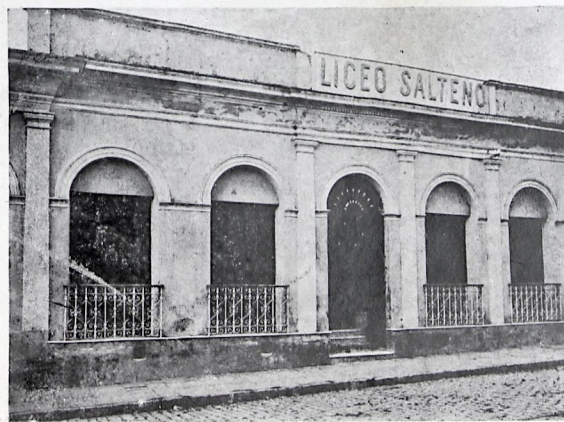
CASA DEL SIG. BELLAGAMBA DOMENICO
