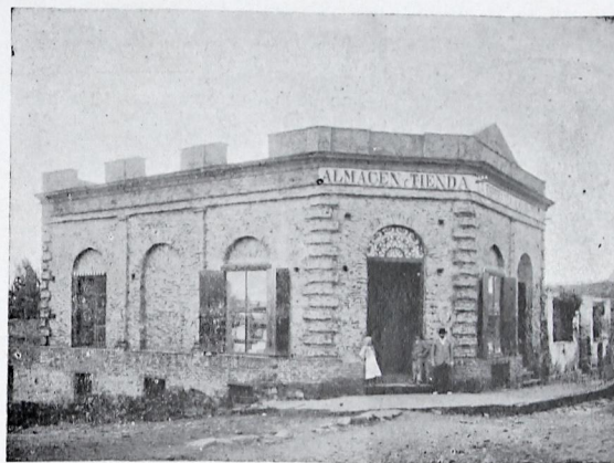
FACCIATA DELLA CASA TRIACA LEOPOLDO
