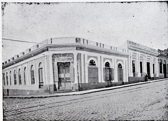
FACCIATA DELLA CASA DE REGIBUS ADAMO
