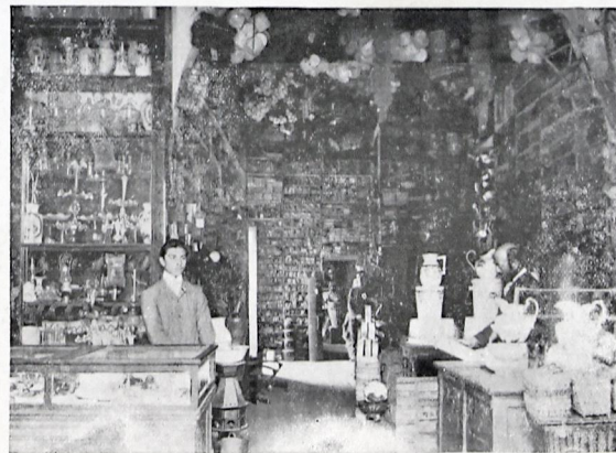
INTERNO DELLA CASA CESCONI
