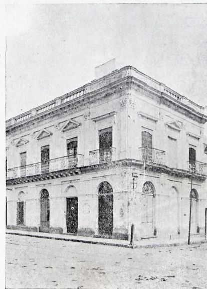
FACCIATA DELLA CASA GARRASINO CARLO.
